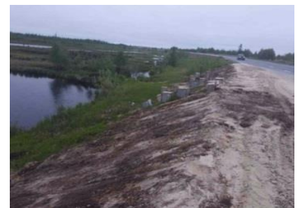
Рисунок 7. Общий вид экспериментального участка с установленным геотехническим оборудованием
