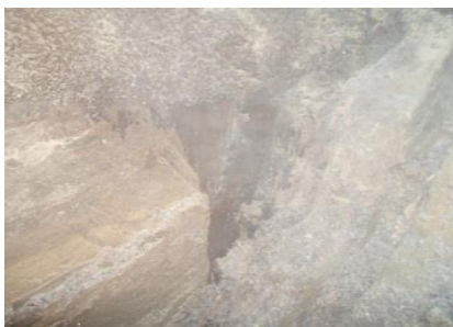
Рисунок 5. Фильтрация воды на границе «основание-земполотно» (февраль-март)
