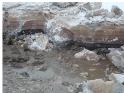
Рисунок 6. Водоем вдоль южной откосной части земполотна (февраль-март)
