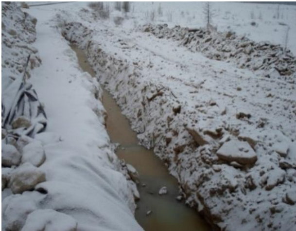
Рисунок 5. Скопление воды в технологической траншее
