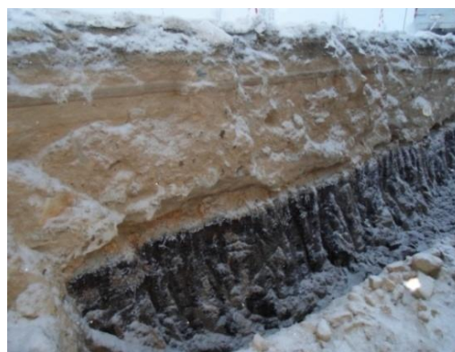
Рисунок 4. Толща талого торфа в основании автодороги (февраль-март 2013г.)
