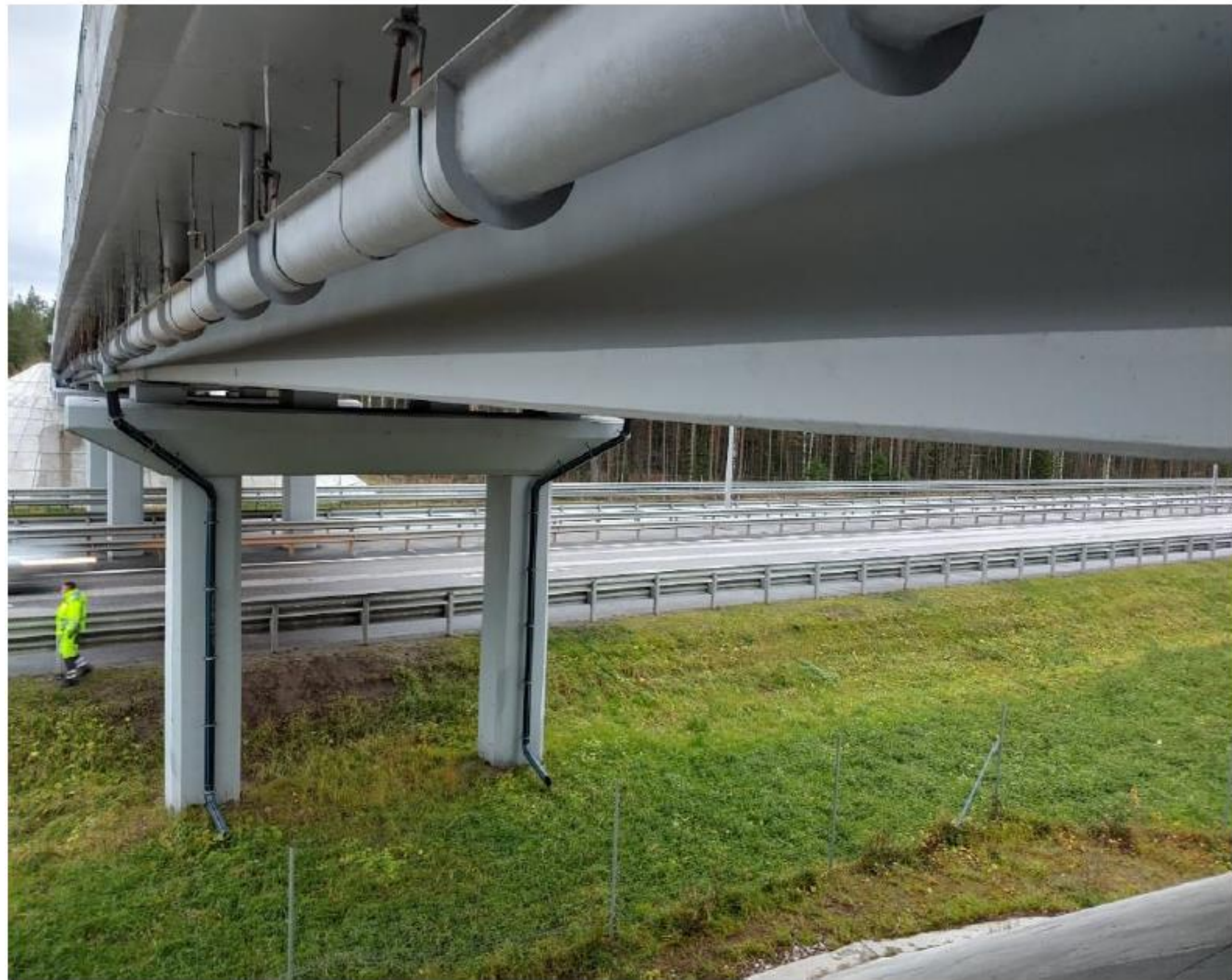
Путепровод с применением карбоновой арматуры на км 513+175 М-11 «Нева»
