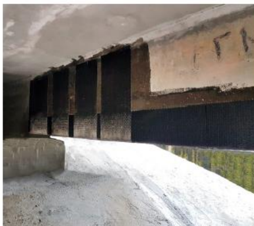
Путепровод через Ж/Д ЕКАД.
