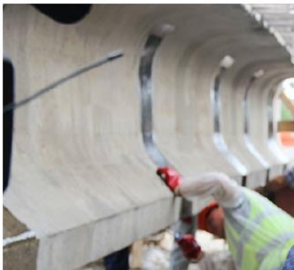
Северный мост г. Череповец
